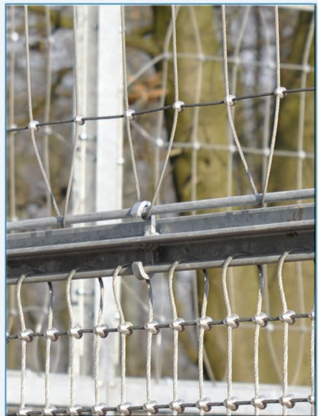
In der Variante “light” ab einer Höhe von 2,0 m mit einer Maschenweite von 100 x 200 mm
